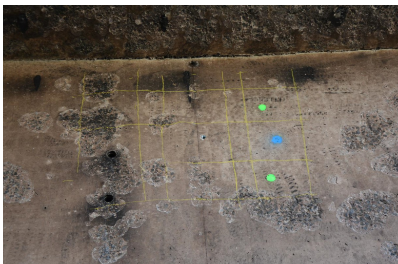
Piédroit côté Brest – Eclats de béton superficiels (extrait Cerema)
